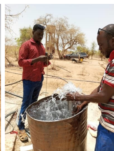
Probelauf für die neue Pumpe
