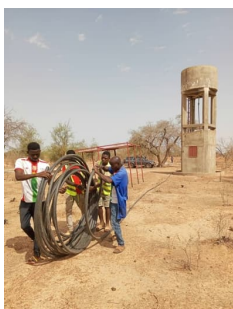
Die Leitung zum Bohrloch wird gelegt
