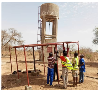
2 zusätzliche Solarmodule werden montiert
