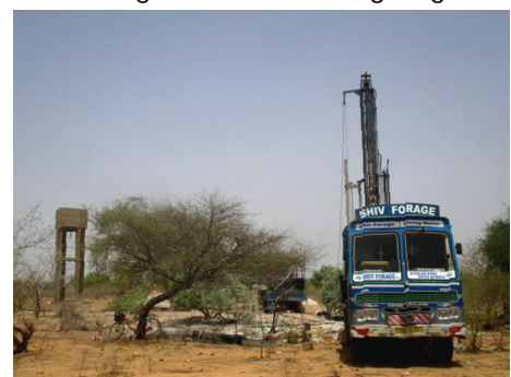
In 80 m Tiefe stößt die Bohrung auf ein 44 m mächtiges Wasserreservoir
