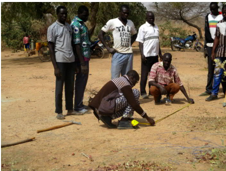
Aufmessen des Wasserturms am höchsten Punkt des Geländes
