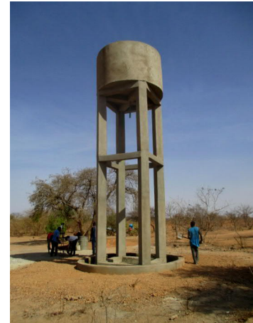
Der fertig verputzte Wasserturm am 18. Mai 2020
